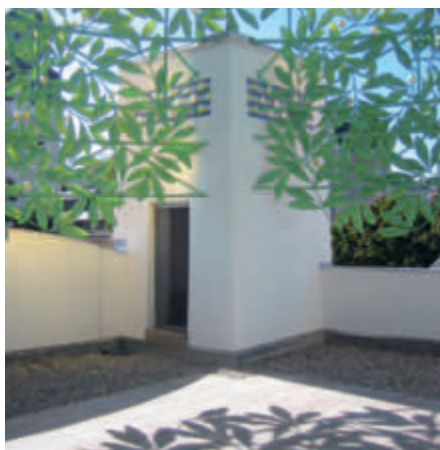
Die Situation nach der Sanierung mit Blick auf Pylon mit integriertem Rückkühlwerk; die Luftansaugung passiert horizontal über die Gitterrosttür, die Ausblasung vertikal über das Dach.
