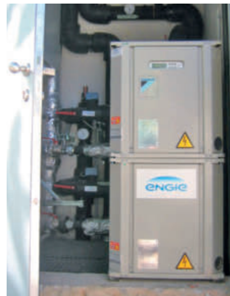
Ansicht Nordpylon mit neuer Wetterschutztür: Blick ins Innere auf die neue wassergekühlte Kältemaschine inkl. Schaltschrank und Hydraulikkomponenten; Wartung von einer Stirn- und Längsseite.
