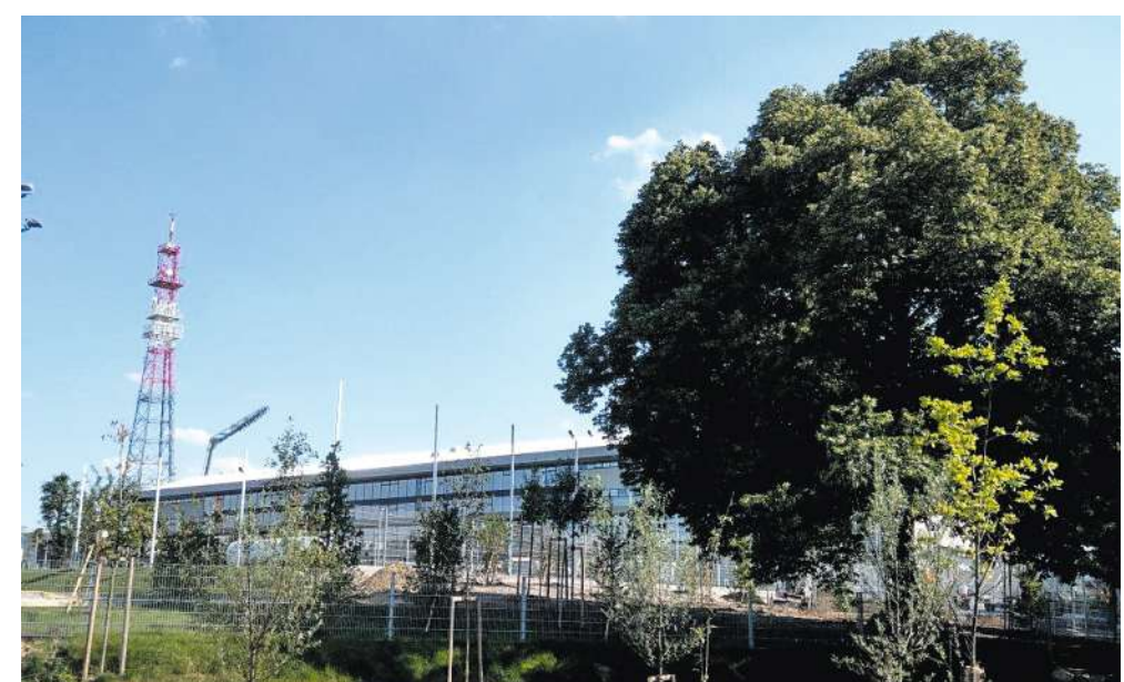
Über 300 neue Bäume wurden im Zuge des Stadionbaus gepflanzt
