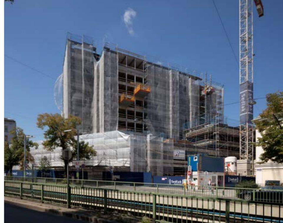
Die Betonskelettkonstruktion des Hauptgebäudes der SVA auf der Wiedner Hauptstraße konnte erhalten werden – das restliche Gebäude wurde umfassend saniert und energetisch auf den neuesten Stand gebracht
