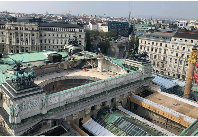
Abbildung 1: Sanierung des Parlaments in Wien (© Gisela Gary/Vasko+Partner)
