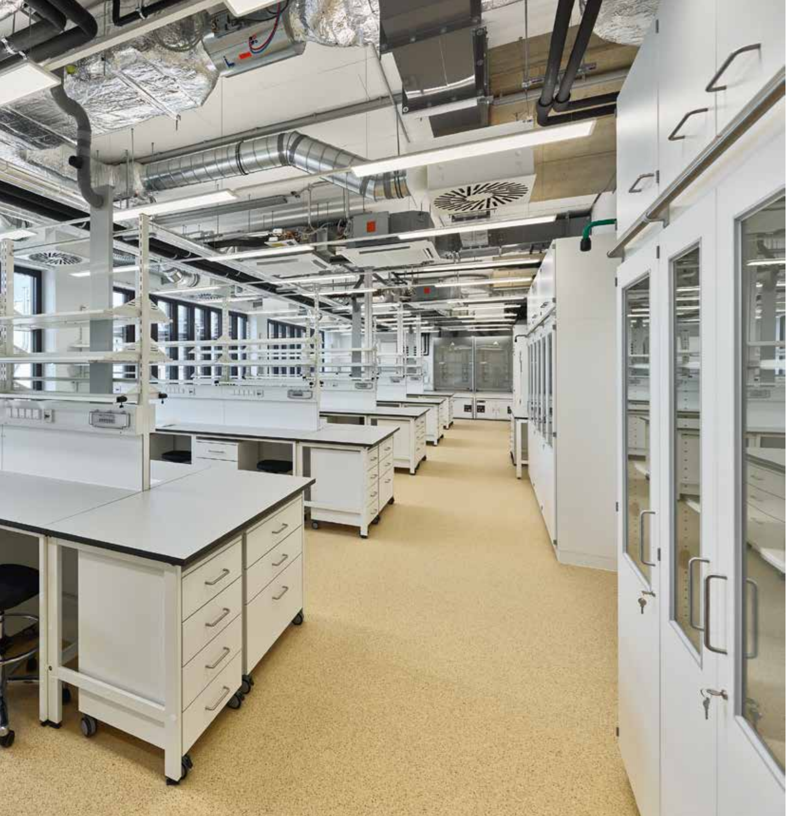
Die Abluft aus den Labors wird der Wärmerückgewinnung zugeführt und reduziert den Heizwärmebedarf um ein Drittel. Heat recovery from the laboratory exhaust air improves the heat requirement by about a third compared to conventional laboratory buildings.
