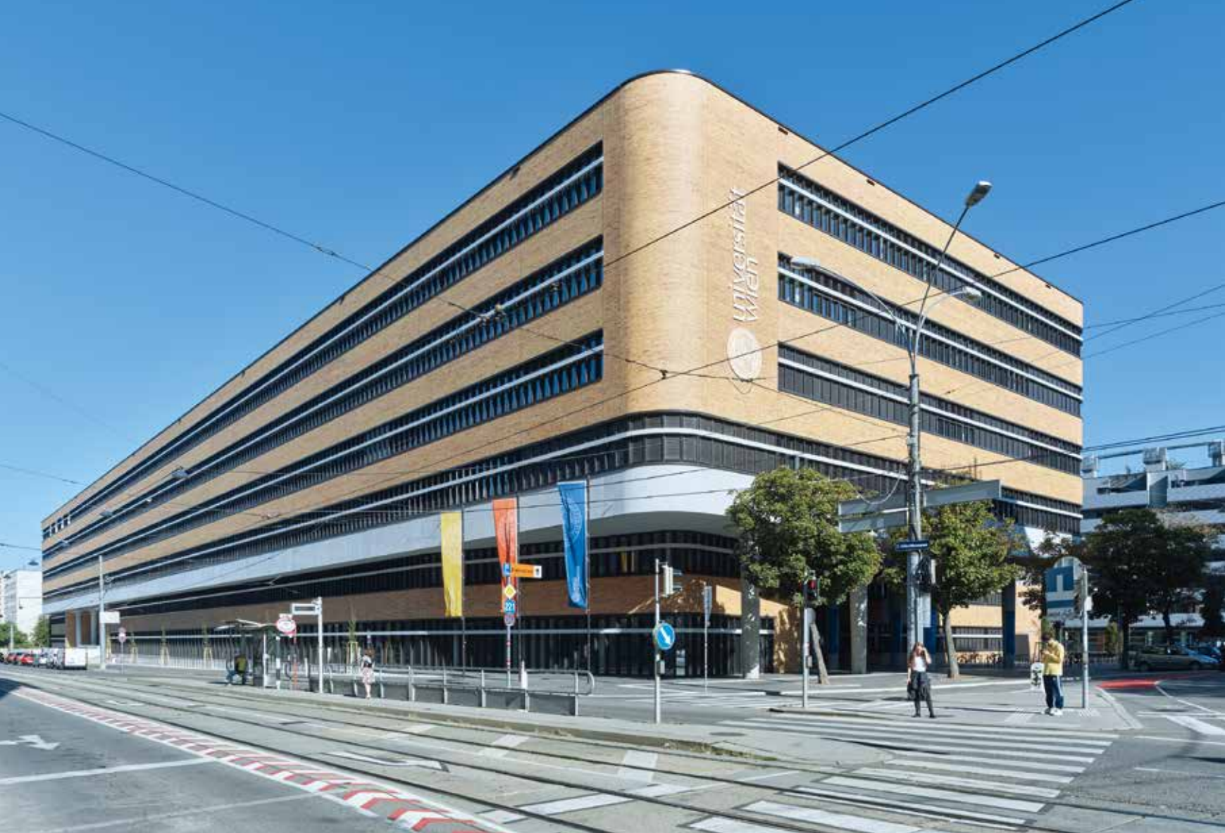
Die vorgehängte Klinkerfassade ist 183 m lang und grenzt die Anlage gegen die Hochfrequenzstraße ab. The west facade is 183 m long and draws a line to the high-frequency street.
