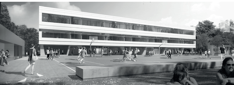
Erstmals gibt es bald eine Schule mit Nullenergie-Turnsälen – die Wiener Schule Enkplatz verfügt über ein zukunftsweisendes, technisch einfaches Konzept (Foto: Riviera Moretti)
